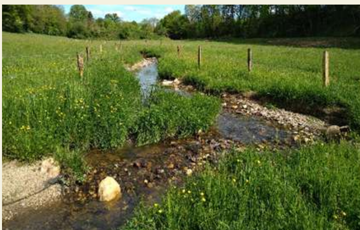
Chantier terminé 6 mois après travaux
