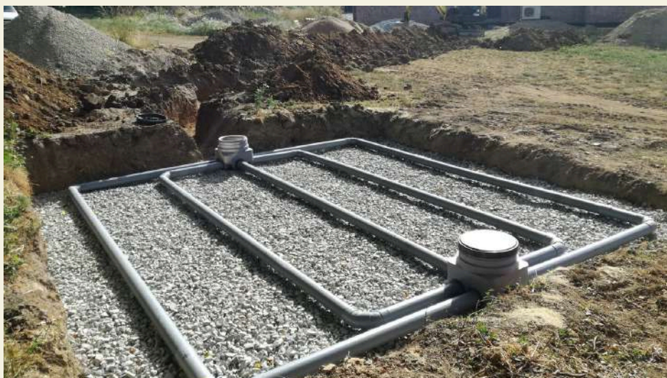
ANC: Installation d'une filière de traitement par filtre à sable vertical non drainé de 5 EH. Trémouilles 2017
