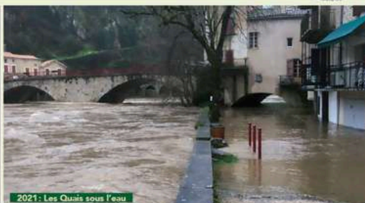
2021 : Les Quais sous l'eau
